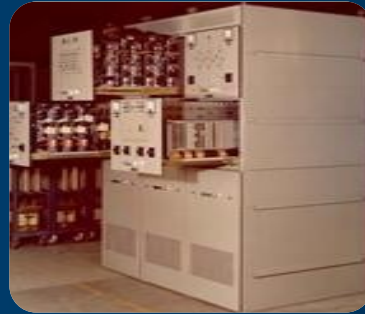
Statische USV mit Transformator
