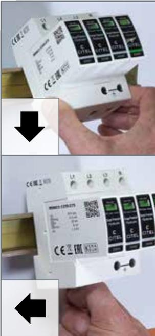
Das Überspannungsschutzgerät wird auf die Schiene geschoben, bis es einrastet.
